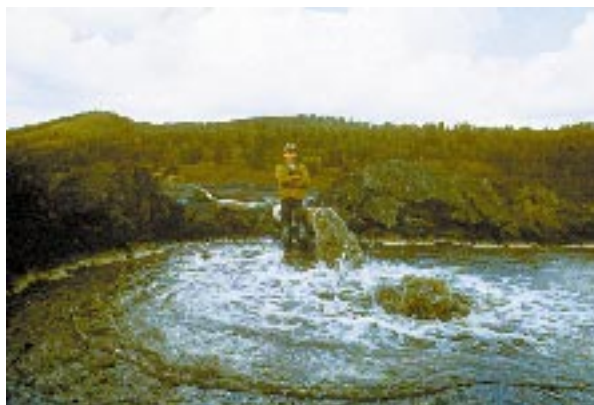
Рис. 4. Намыв золы из пульпопровода с образованием искусственного озера и осадков золы уноса (фото Е.Н. Огородниковой).
